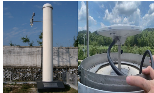
图 3 吕田站天线罩拆除前(左图)、后(右图)
